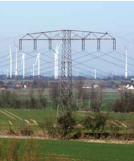
Im Zuge der Energiewende sollen viele bestehende Leitungen ertüchtigt werden.
