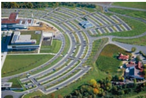
Dieser überdimensionierte, flächenzehrende Parkplatz eines Forschungszentrums ist in unmittelbarer Nähe zum Schwäbisch-Fränkischen Wald in der freien Landschaft errichtet worden.
