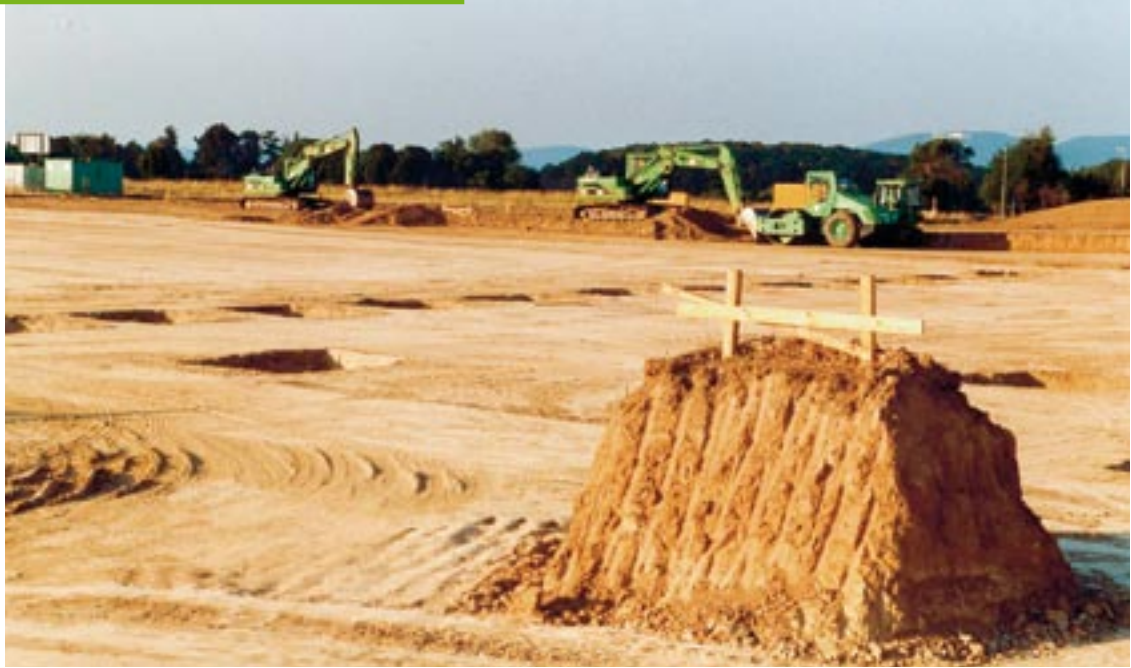
Enormer Landschaftsverbrauch durch den Bau eines Einkaufszentrums in der freien Landschaft.
