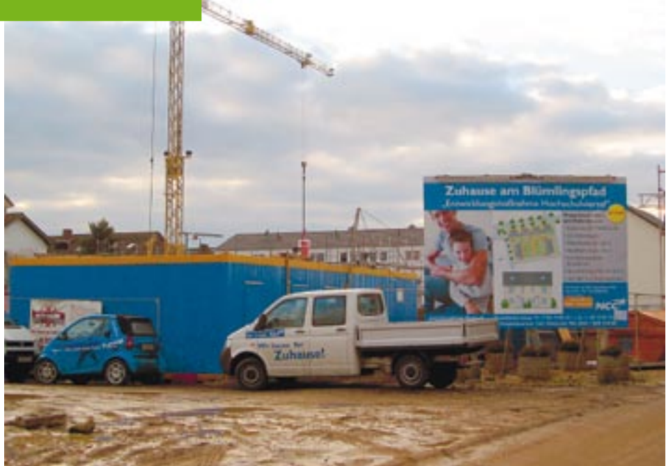
In einem Wohngebiet in Rheinbach entstehen Doppelhaushälften und Reihenhäuser im Rahmen eines Innenentwicklungsprojektes.
