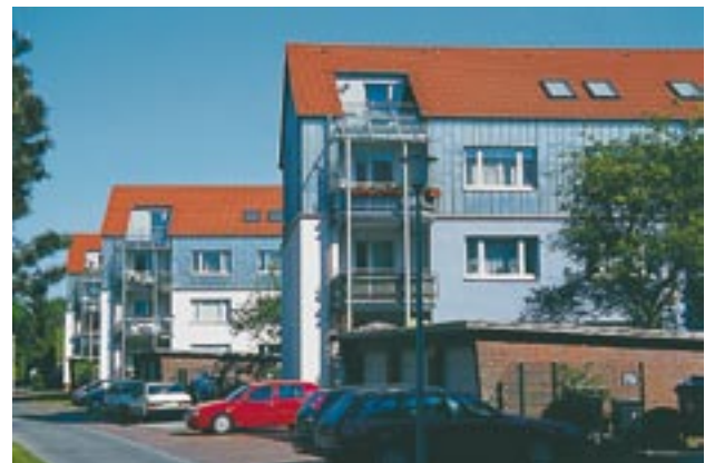
Aufstockung von Wohngebäuden.
