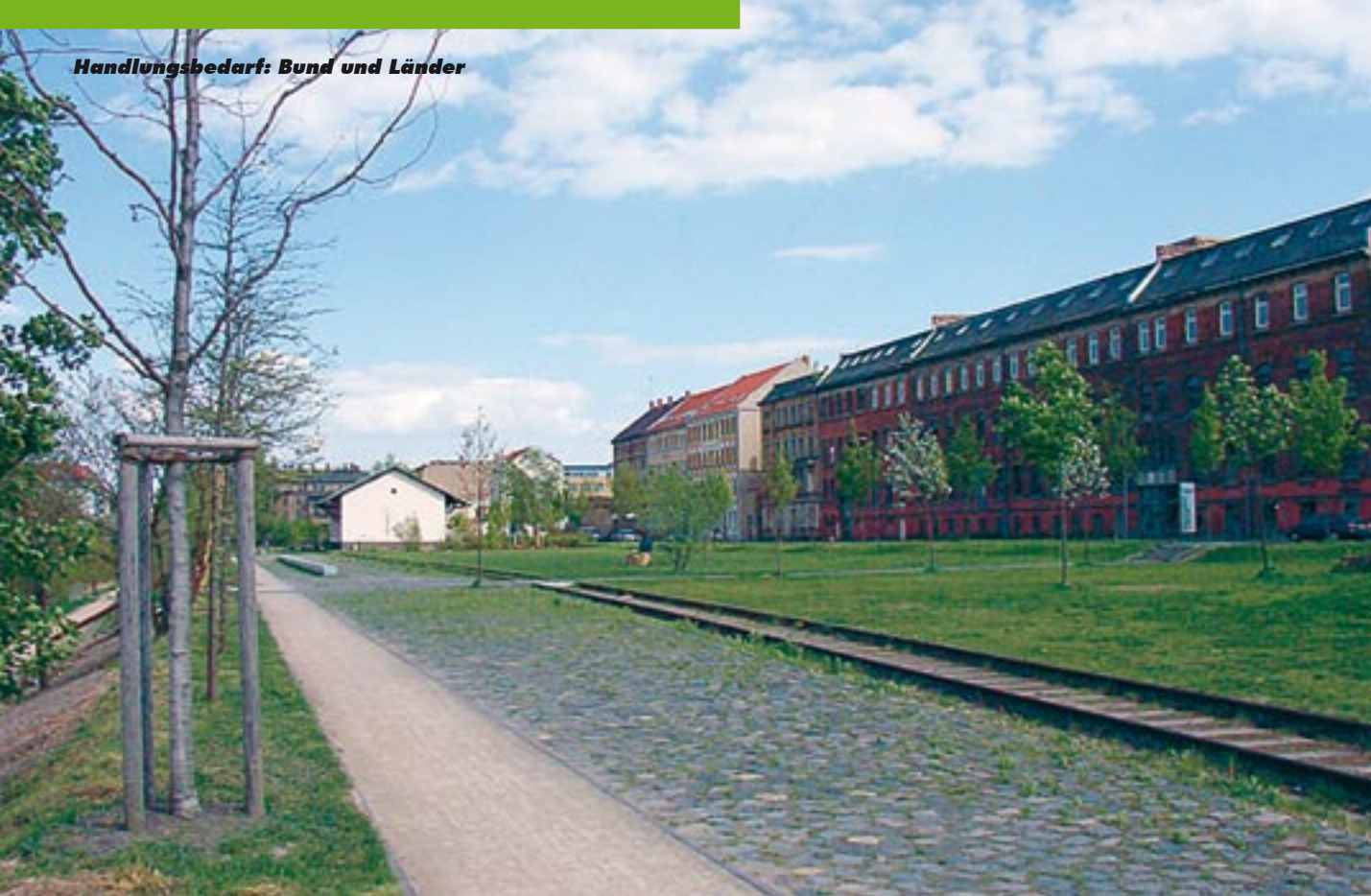
Stadteilpark Plagwitz, Leipzig: Die Revitalisierung des Stadtteils Plagwitz stellte von Beginn an eine der zentralen Entwicklungsmaßnahmen der Stadt Leipzig dar. Um dem wirtschaftlichen Strukturwandel zu begegnen, die Attraktivität des Gebietes wieder herzustellen und die qualitativ herausragende Bausubstanz zu erhalten, integrierte die Stadt Leipzig das Planungsgebiet in ein gesamtstädtisches Entwicklungskonzept. Inzwischen steigt das Image dieses gründerzeitlichen Stadtteils und er wird von der Bevölkerung bewusst wahrgenommen.
