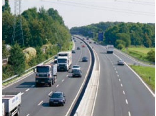
Zerschneidung der freien Landschaft durch Verkehrswege.
