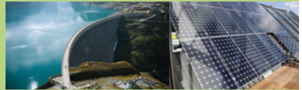
Staudamm in Österreich
