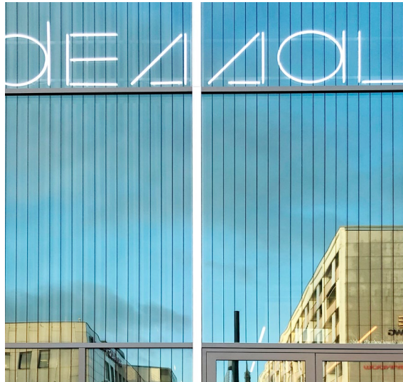
Zur Sicherung gegen Vogelanprall am neuen Bauhaus Museum in Dessau wurden mehr als 2700 m 2 Fassadenglas nachträglich mit einem ausgeplotteten Linienmuster versehen.
