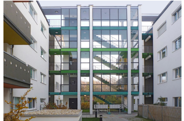
Die von Glaswänden und verglasten Gängen ausgehende Gefahr wird verschärft, wenn Gebäude auf beiden Seiten die Vögel unausweichlich zum verglasten Hindernis lenken.
