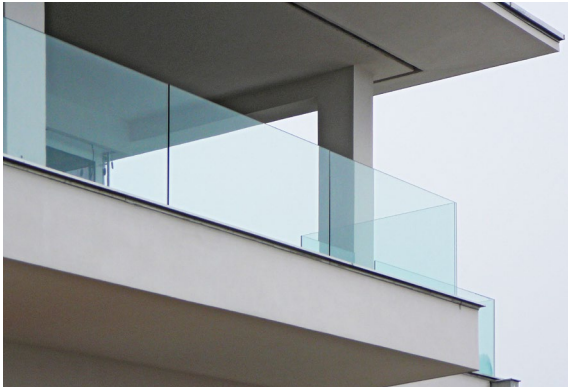
Vögel überfliegen oft in knappem Abstand die Gebäudekante, ohne die gläserne Brüstung wahrzunehmen.
