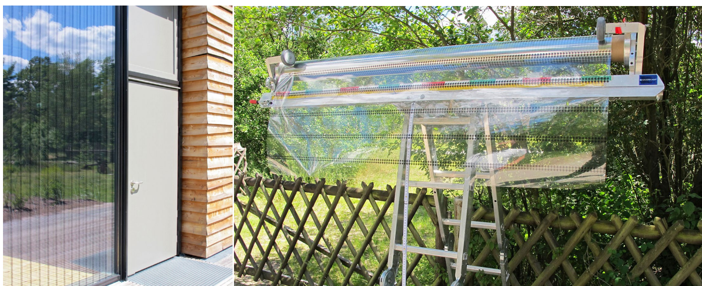
Bedruckte Folien werden vollflächig aufs Glas aufgebracht.
