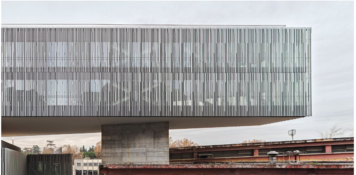
Die Città del Sole («Sonnenstadt») in Rom des Architekturbüros Labics ist eine Mehrzweckanlage mit öffentlichen und privaten Funktionen. Sowohl die Fassadengestaltung aus Aluminiumprofilen als auch die transluzenten gläsernen Lamellen an den unterschiedlichen Gebäuden sorgen gleichermaßen für Sonnen- wie auch für Vogelschutz.
