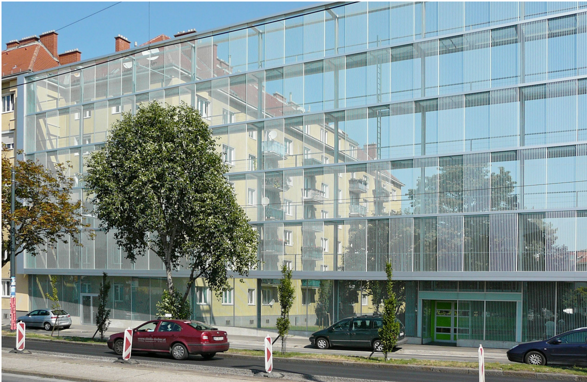
Die dreidimensionale Struktur der Lärmschutzwand von Treusch architecture am Theodor-Körner-Hof in Wien wird durch das verwendete Vogelschutzmuster bewusst optisch verstärkt.
