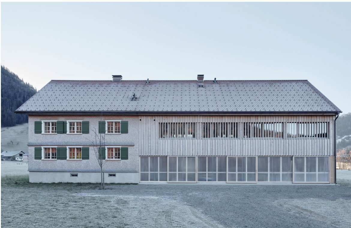
Im Zuge einer Umnutzung haben gruber locher architekten bei der Sanierung des denkmalgeschützten Hauses Grossenbündt in Hittisau die Erschliessungsflächen hinter einer semitransparenten Raumschicht zusammengefasst. Die Struktur der traditionellen Holzfassade wird aus Sonnenschutzgründen über die langen Fensterbänder im Obergeschoss weitergeführt, während die klassischen Kastenfenster des Wohntraktes erhalten blieben. Vögel können diese Materialien und Strukturen gut erkennen.
