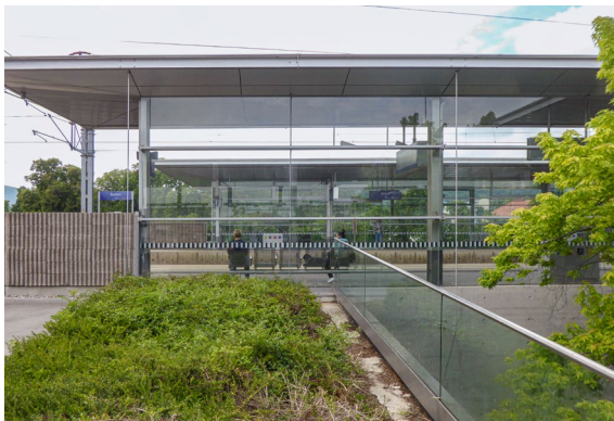
In grüner Umgebung sind Glaskonstruktionen wie dieser Bahnhofszugang besonders gefährlich für Vögel.
