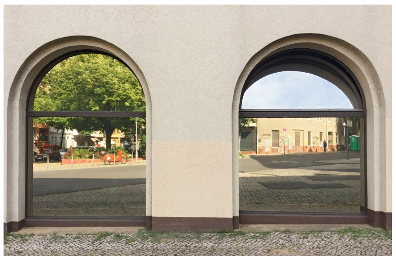
Spiegelnde Sonnenschutzfolien erzeugen realistische Spiegelbilder: Vögel nehmen diese Fenster als Durchflugsopion wahr.
