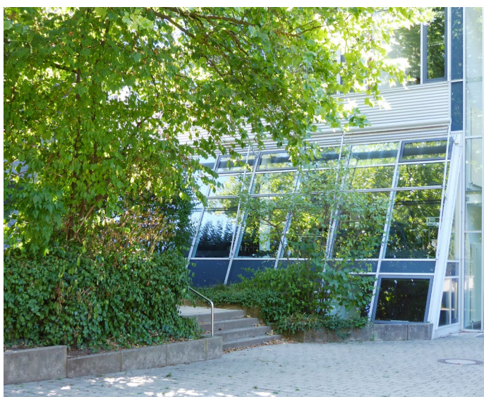
Die Spiegelungen an dieser schrägen Glasfront eines Schulgebäudes sind ebenso klar wie an einer senkrechten Scheibe und bergen somit ein hohes Kollisionsrisiko.
