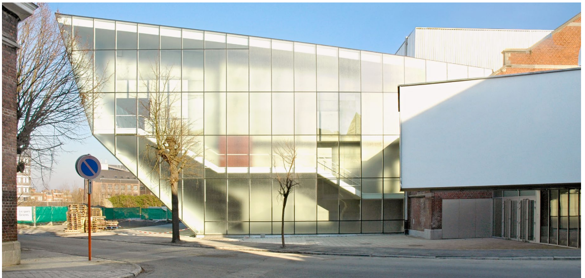
Eine Fassade aus strukturiertem und mattem Glas sorgt für ausreichend Tageslicht im Gebäude, während kleinere Klarglasfenster sparsam und gezielt nur dort zum Einsatz kommen, wo ein Ausblick gebraucht wird. Am Théâtre le Manège in Mons (Belgien) arbeitete das Atelier d'Architecture Pierre Hebbelinck mit diesem spannenden Mix aus verschiedenen Glasstrukturen.
