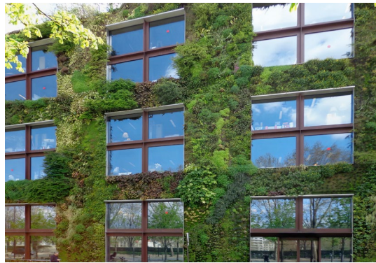
Fassadenbegrünung am Musée du Quai Branly in Paris. Solche Massnahmen zur Förderung der Artenvielfalt und zur Verbesserung des Stadtklimas müssen Hand in Hand mit Massnahmen gegen Vogelanzug gehen.
